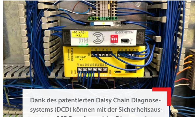
Dank des patentierten Daisy Chain Diagnosesystems (DCD) können mit der Sicherheitsauswertung SCR P umfangreiche Diagnosedaten jedes angeschlossenen Gerätes zum Beispiel über Ethernet ausgewertet werden. In der gesamten Anlage finden sich drei der Sicherheitsauswertungen.
